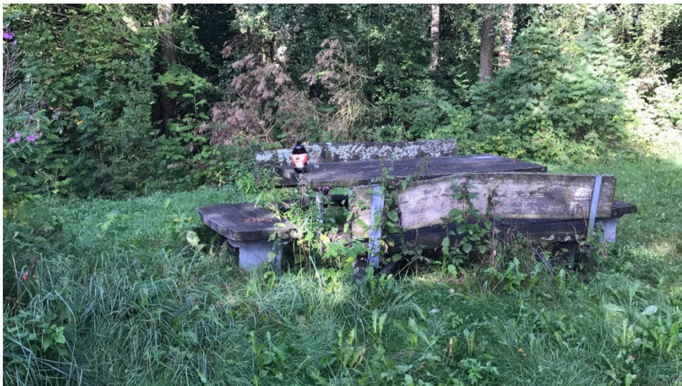
Bild 6. Bristfälligt underhållen rastplats i delområde 3.
